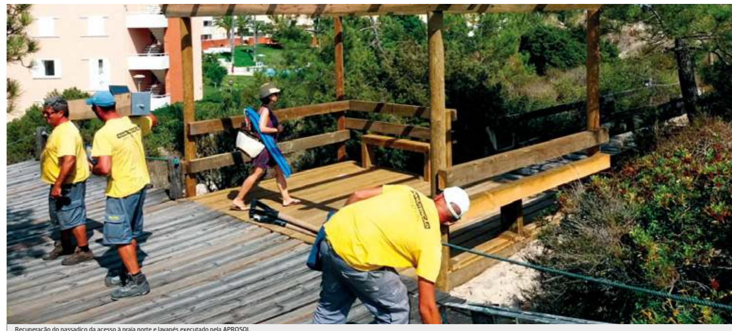
Recuperação do passadiço da acesso à praia norte e lavapés executado pela APROSOL.
