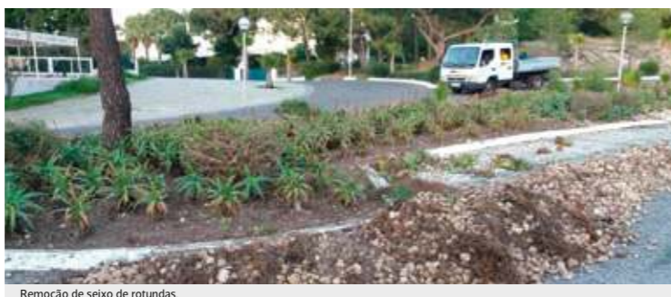
Remoção de seixo de rotundas.
