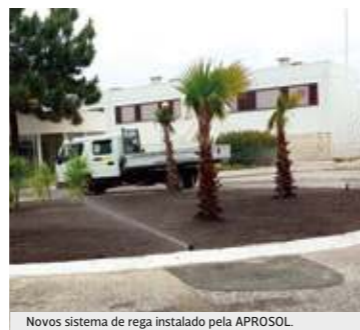
Novos sistema de rega instalado pela APROSOL.
