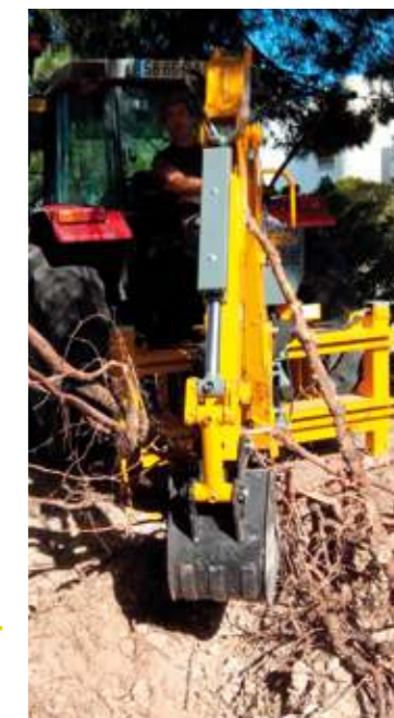
Arranque de raízes para recuperação de passeios e acessos.
