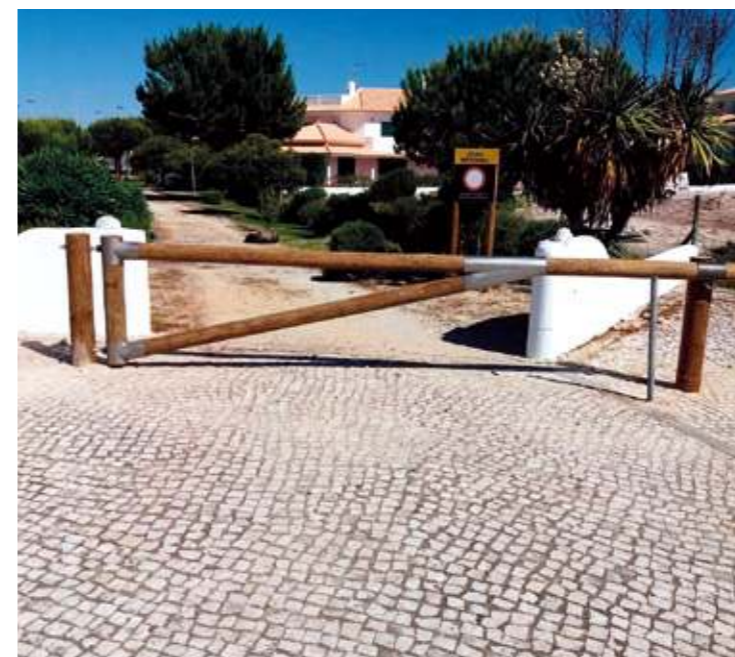
Novo portão para acesso à zona do circuito de manutenção, instalado pela APROSOL.
